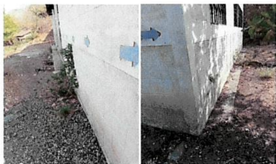
Foto 11: Reemplazamiento de Cuneta fundida de 60 cm X 0.10 cm de espesor.
