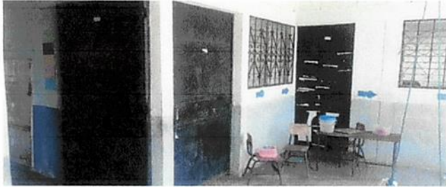
Foto1: Mantenimiento de 6 puertas de 1.20 mts X 2.15 mts (limpieza, Refuerzos y Pintura)
