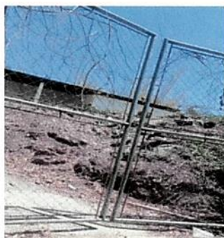
Foto 9: Mantenimiento de Porton Existente de 2.77 mts x 2.97 mts (Limpieza, pintura y pasador)
