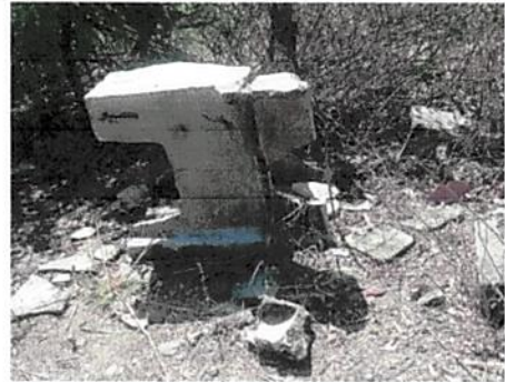
Foto 4: Colocación de Pila de Concreto nueva.
