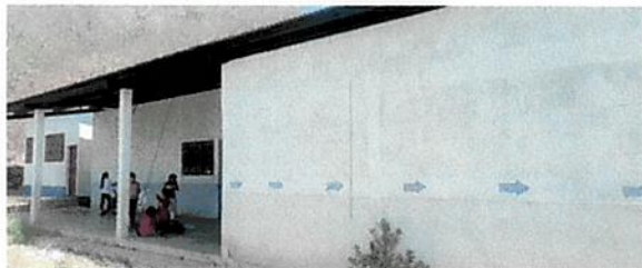
Foto7: Colocación de Pintura en Establecimiento Interior y Exterior
